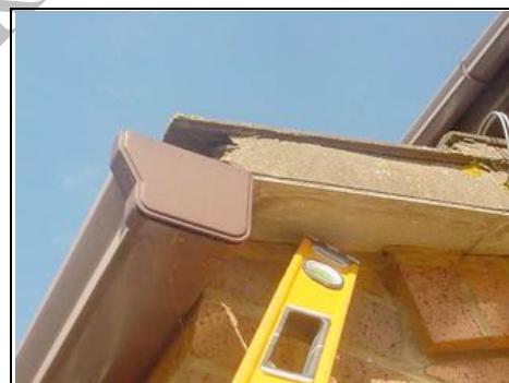
Asbestos verge
